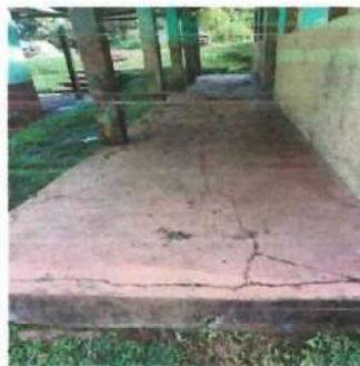
Foto 2: Se necesita remozar la losa de patio se encuentra en mal estado
